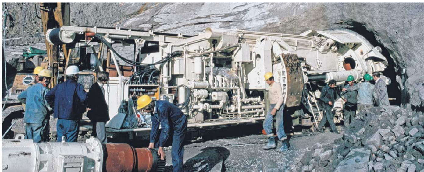
Vor 40 Jahren starteten die Bohrarbeiten für den Pfändertunnel in Bregenz.
